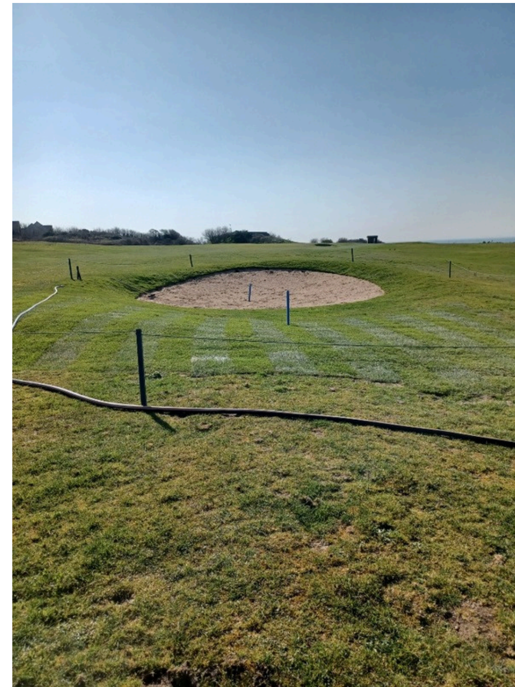
Rénovation des bunkers du 1, 14 et 15
